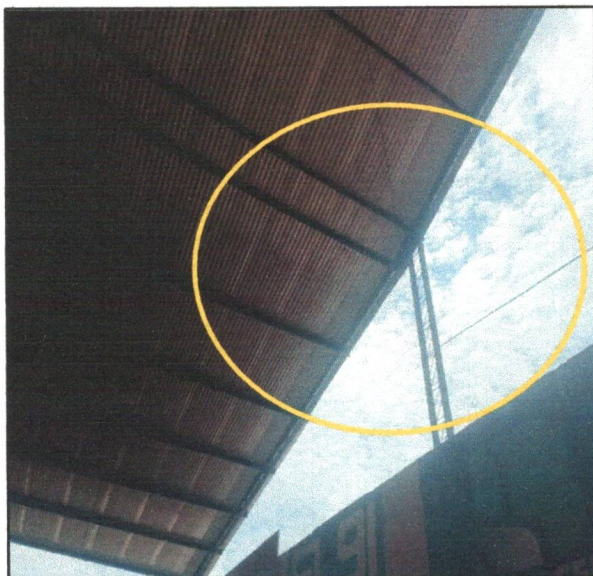
Fotografia 17: Cobertura da quadra danificada devido às fortes chuvas.
