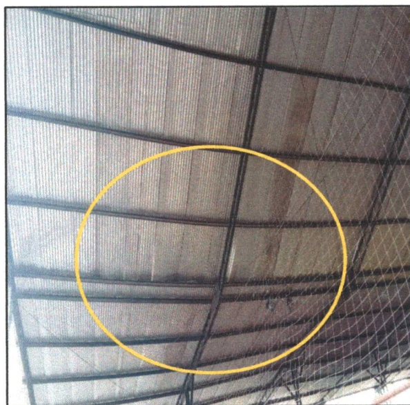
Fotografia 19: Cobertura da quadra danificada devido às fortes chuvas.
