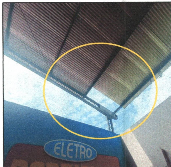
Fotografia 16:Cobertura da quadra danificada devido às fortes chuvas.
